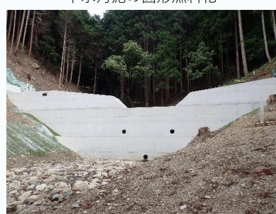
土砂災害防止施設（治山ダム）の整備
